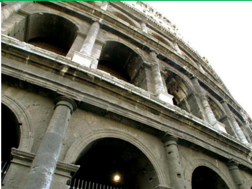
Fachada exterior con la superposición de órdenes: toscano, jónico, corintio y pilastras corintias en el ático.
